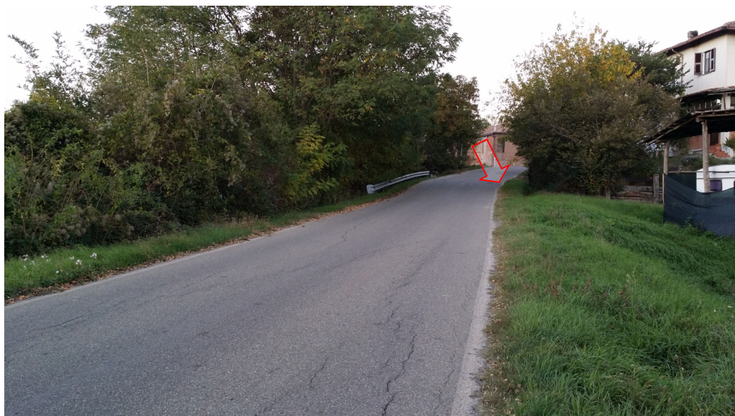
Figura 1.4: Tratto di viabilità di via Vittorio Veneto soggetto a fenomeni di subsidenza (la freccia indica la zona di maggior evidenza del fenomeno - ripresa da sud).
